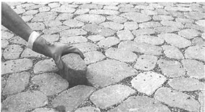
Arena-Pflaster erinnert an gespaltene Kiesel. Es lässt sich ohne Einschniden verlegen, ist ausdrucksstark und ökologisch wirksam.
