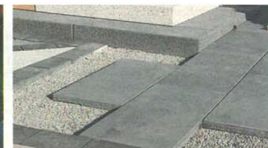
Neben der Fuge ist die Bettung wichtig beim Verlegen der Betonplatten. Sie muss das Wasser durchlassen.
