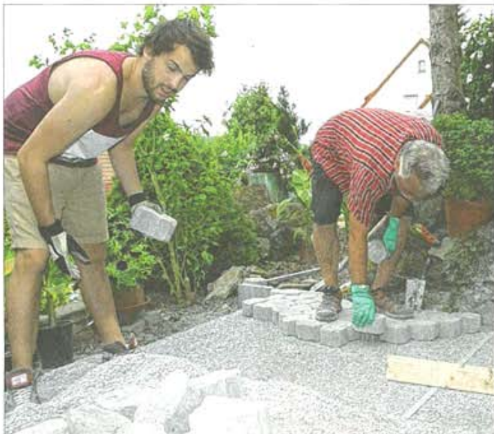
Der Beginn der Pflasterarbeiten: Das Splitt-Pflasterbett wird mit Hilfe von Metallschienen und einem Brett im benötigten Gefälle abgezogen.
