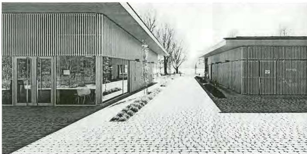
Zu den Auflagen bei der Neugestaltung des Bade- und Campingplatzes Hegne am Bodensee gehörte die Wasserdurchlässigkeit des Bodenbelags. Das Pflastersteinsystem Arena erfüllt diese Anforderung.
